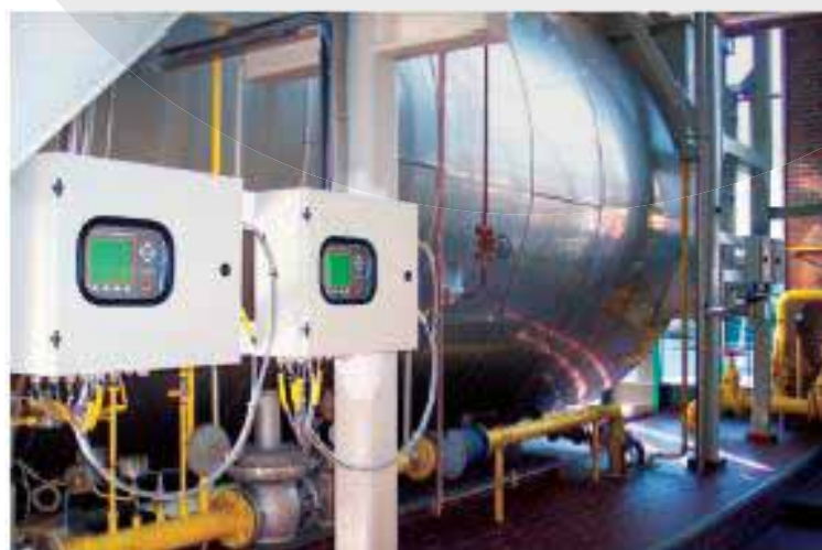
圖二、O 2 監測設施使鍋爐效率大幅提升
